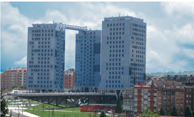
Residencial Montenuño, Oviedo
