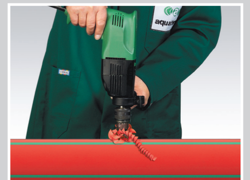
1. Perforar el tubo (con taladro convencional) (30 seg.)
