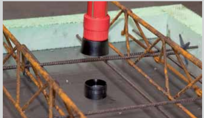
La parte superior de la salida del rociador es conectada con la base del mismo.
