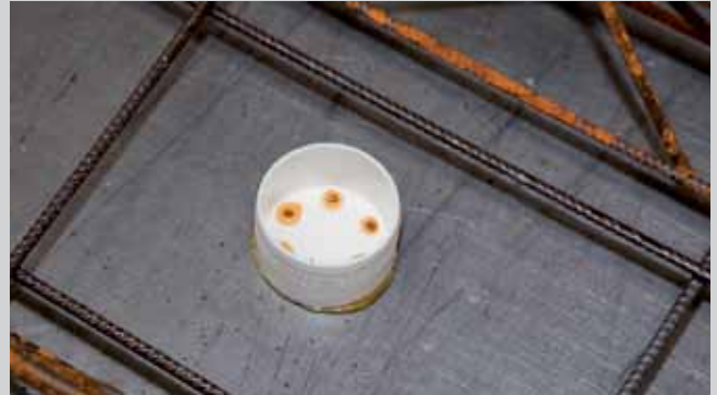
Base de la salida del rociador Art.-No. 4114190 para rociadores empotrados. Fijación mediante adhesivo en caliente.
