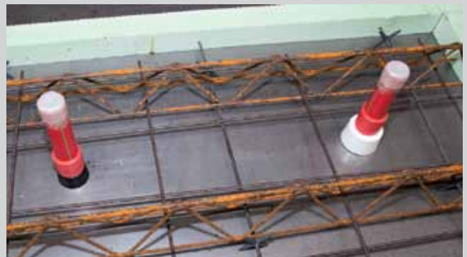
1. Tipo de conexión: rociadores vistos
