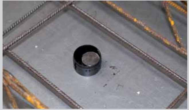
Base de la salida del rociador Art.-No. 4114180 para rociadores vistos. Fijación magnética.
